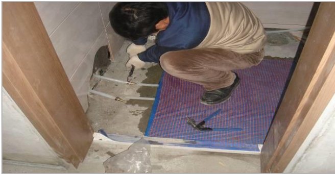
③ ADD욕실패널 설치
